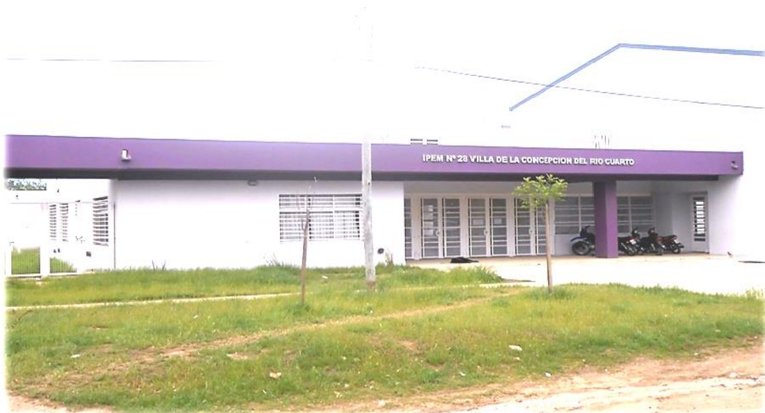
Figura 1. Vista exterior de la Escuela IPEM 28 “Villa de la Concepción- Río Cuarto. Fotografía de la autora
